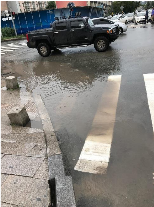
排水システムがなく、雨が溜まった道路
