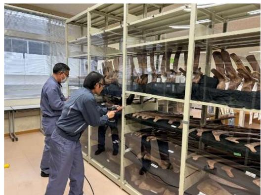
図3. 工作センターの支援を得て、亚克力板のたわみ補正具を取付け
